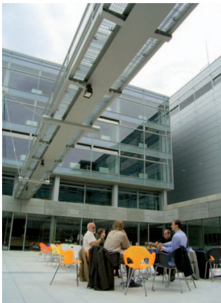
Mendelova univerzita v Brně – ocelová lávka pro pěší
